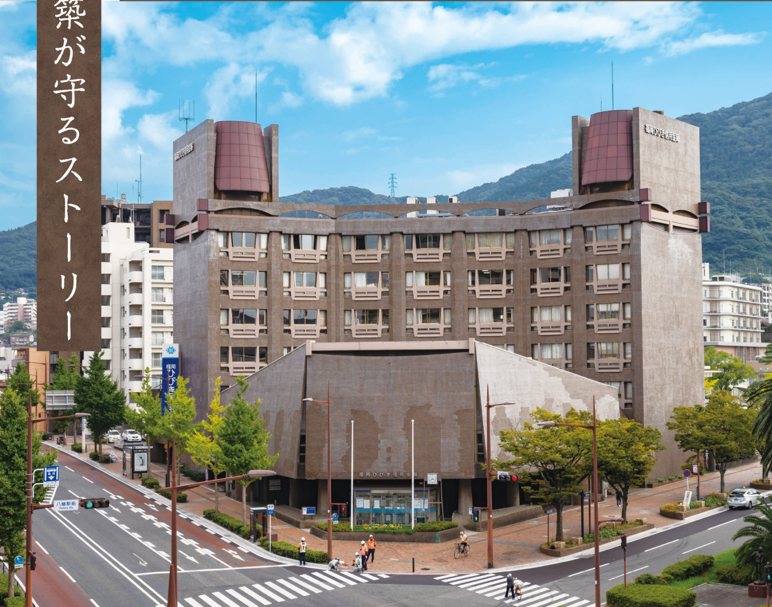
敷地形状を活かした村野建築の外観には、鉄の街北九州を象徴する溶鉱炉をイメージした2つの塔屋が、皿倉山の裾野に際立つ。外壁は全て1枚1枚手作りされた備前焼。
