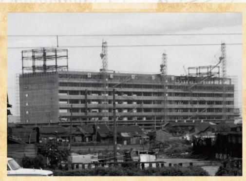
建設工事が進む博多駅ビルを旧博多駅方向から望む。当時最先端のリベット工法による鉄骨組み立て方式が採用された。
