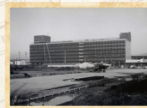
駅ビルは、アルミ工法の金枠に磁石板を組み合わせた外壁や、最先端のスプリンクラーなどの防災設備が評価され、全国建築業協会の表彰を受けた。
