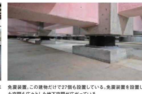
免震装置。この建物だけで27個も設置している。免震装置を設置した空間も広々とした地下空間が広がっている。
