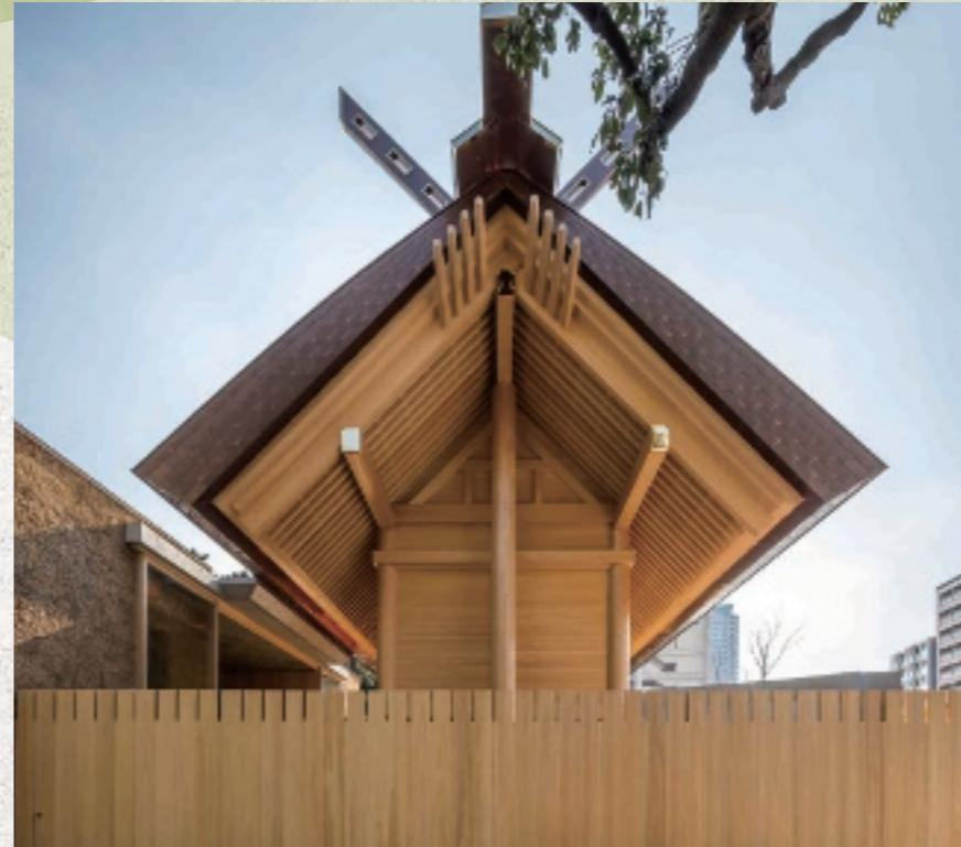
本殿:老朽化と改修の積み重ねで存続が難しいため建て替えを決断。基本様式は神明造だが、従来の25年で遷宮するつくりではなく200年は持ち続けられるように工夫を加えている。
