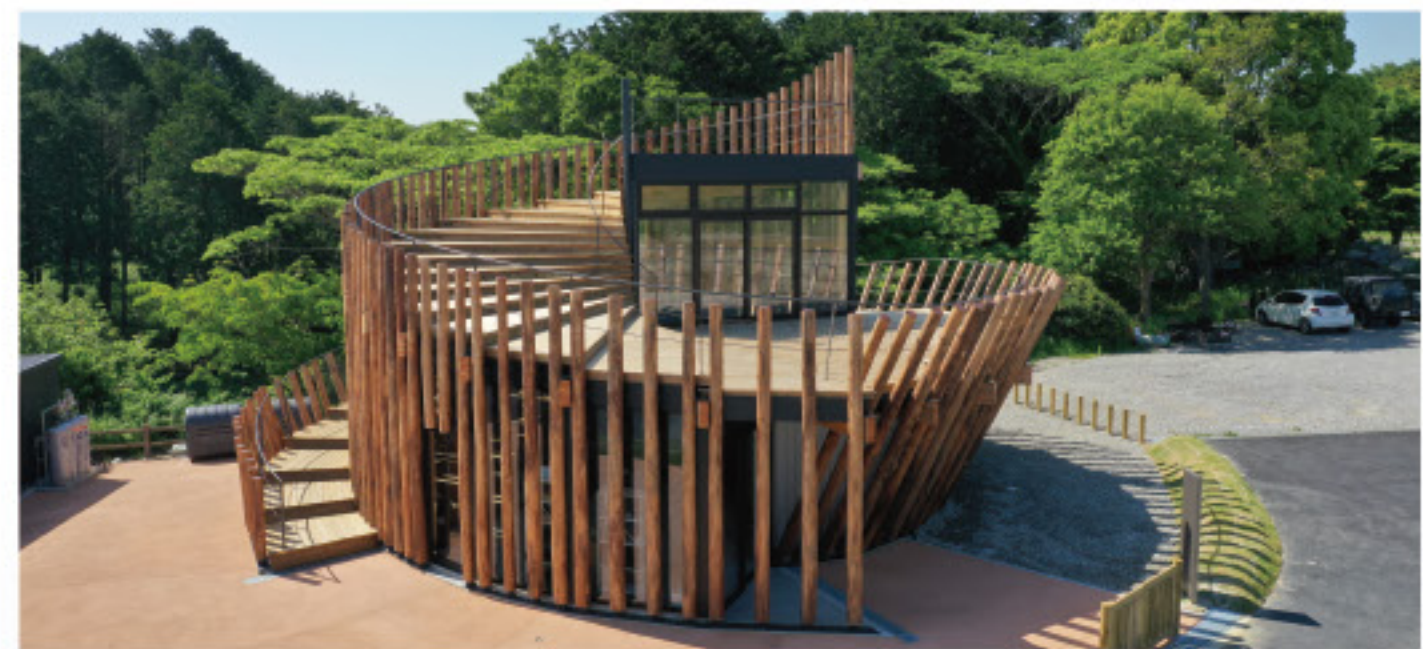
丸太の長さや太さなどを計算し設置された
