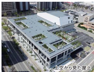
上空から見た屋上
