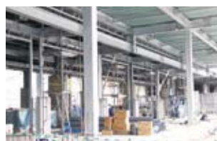
既存棟と増築棟の接続部
