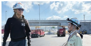
道路舗装工の職人さんに進捗確認
