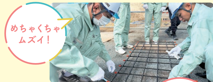
●鉄筋組立体験/鉄筋の結束を行う
