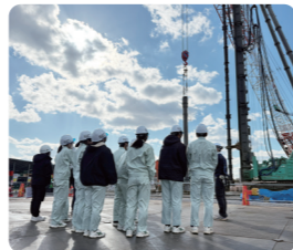
●杭打ち工事見学
