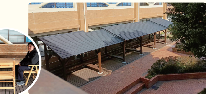
全長18メートルに及ぶ東屋の制作。柱や梁の精度をそろえる難しさや、木材同士を組み合わせる工程に神経を使いながら、骨組みを一つずつ組み上げていきました。
