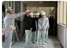
●内装下地工事の説明
