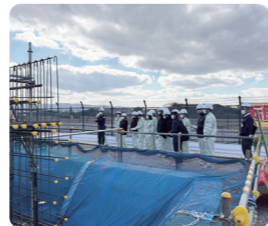
●基礎工事見学
