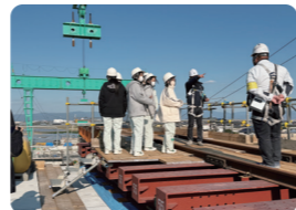
●高所での施工手順の説明
