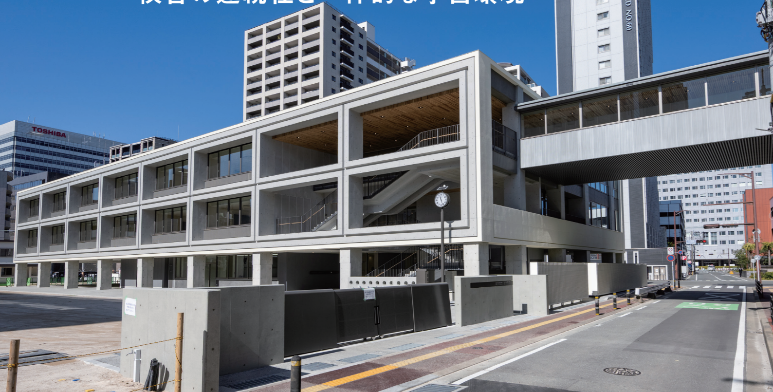
全長約84mある校舎本体と、道路上空を跨ぐ延長約7.5mの上空通路からなる増築校舎。分断された敷地条件に対応し、校舎を立体的に接続する構成として整備された。
