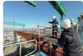
●鉄道上空での橋梁工事の説明
