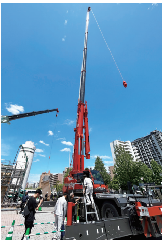
大型重機も設置
