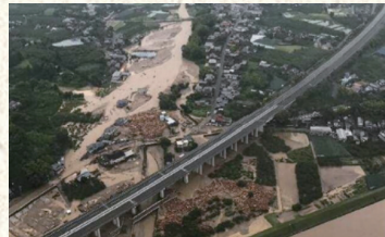
道路・橋梁の被害 道路や橋梁にも被害が及び、地域の移動が妨げられた。
