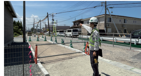
狭い歩道の拡幅と交差点改良を行う「芝原地区歩道整備外工事」。
