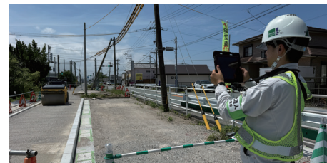
施工状況を写真に記録することも、品質を管理する大切な業務の一つ。
