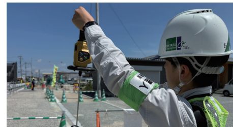
トータルステーションを使い、構造物を設置する位置や高さを確認。
